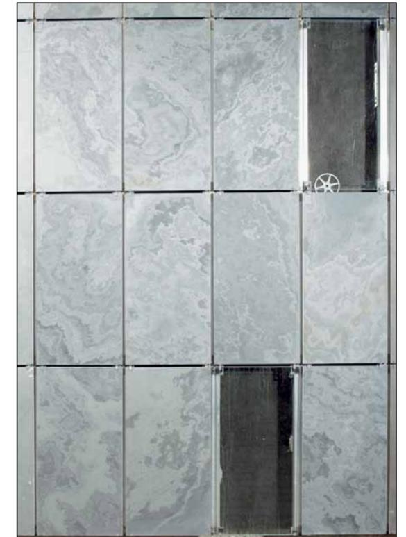
*Pose symétrique verticale, 600 x 300 mm, sur support alu, fixation à l'aide de crochets inox HE130 visibles*
