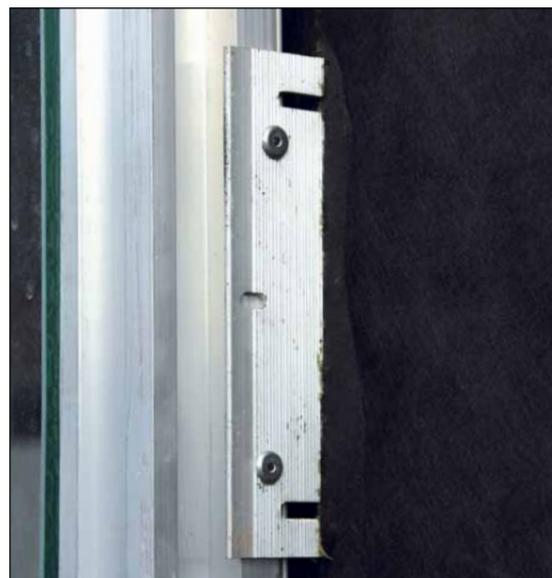
Conformément aux prescriptions statiques, les profilés porteurs seront posés à hauteur d'étage dans les supports muraux en forme de U; ils seront ajustés à l'aide d'un laser vertical ou horizontal, puis rivés.
