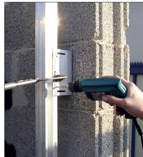
*Diamètre de perçage 5,2 mm*
